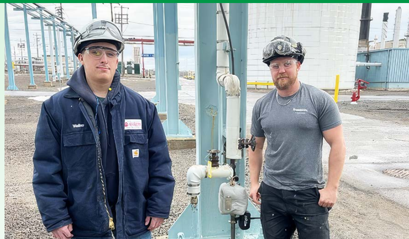
Caleb Moore, étudiant en ingénierie, et Brooks Hoare, mécanicien, avec un purgeur de vapeur sur le site d'Evonik à Maitland, en Ontario.
